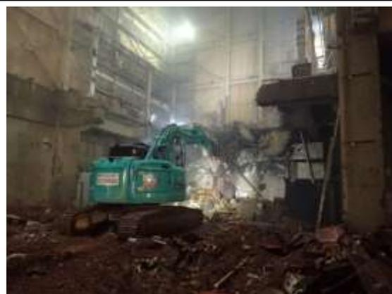
工場棟内部処理設備撤去完了。（写真11-3、11-4）
