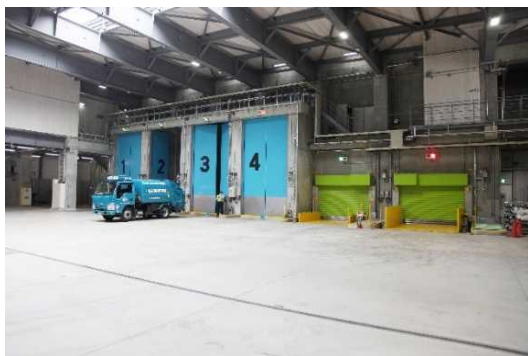
プラットホーム
