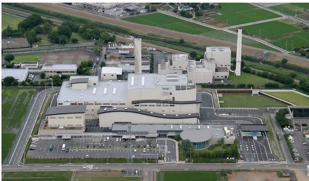
ふじみ野市・三芳町環境センター 平成 28 年 10 月 31 日稼動
