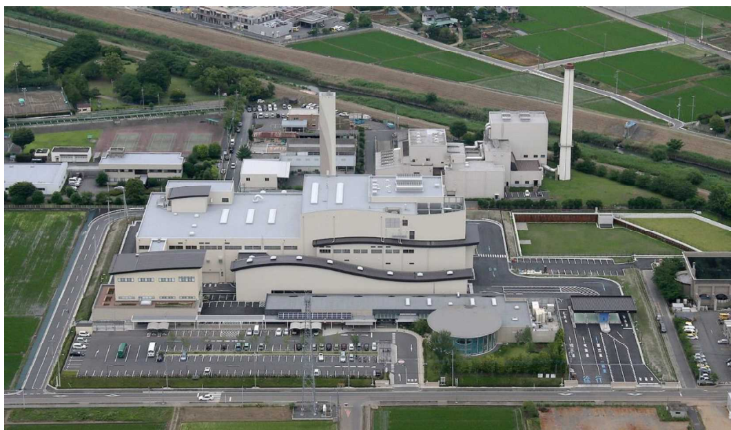
ふじみ野市・三芳町環境センター全景
