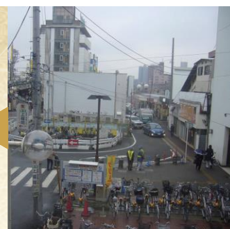
整備前の上福岡駅東口駅前広場
