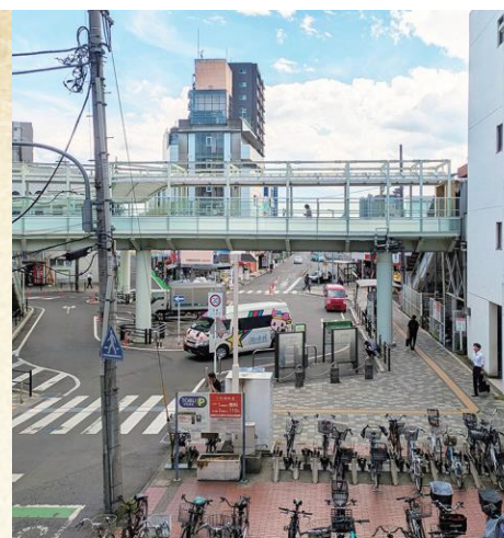
現在の上福岡駅東口駅前広場
