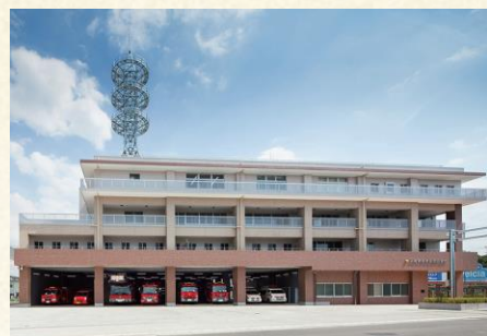
入間東部地区事務組合消防本部
