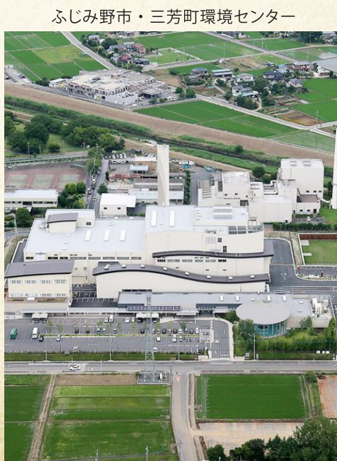
ふじみ野市・三芳町環境センター
