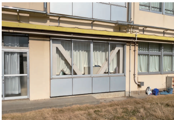
耐震化工事を行った学校
