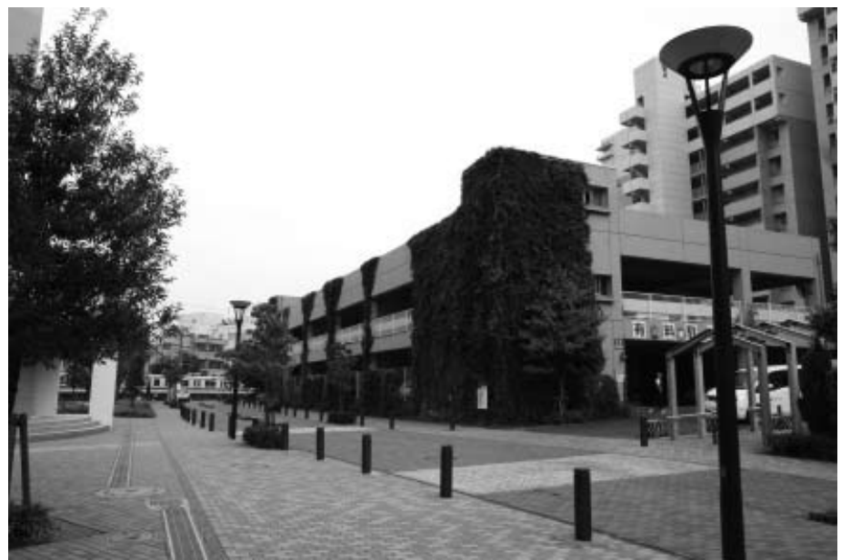
コンフォール霞ヶ丘内の壁面緑化
