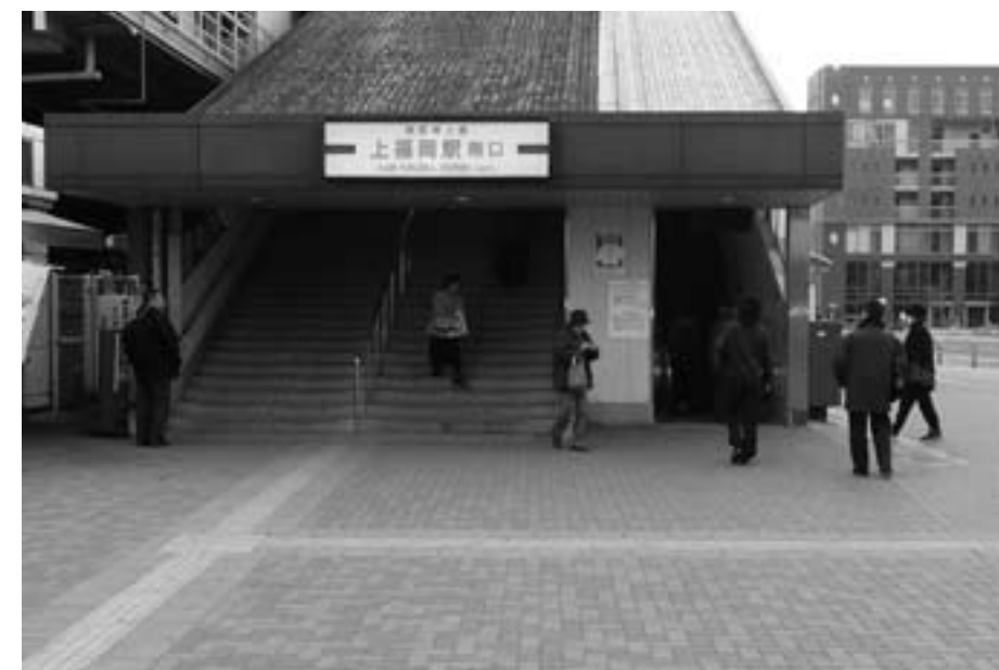
上福岡駅エスカレーター
