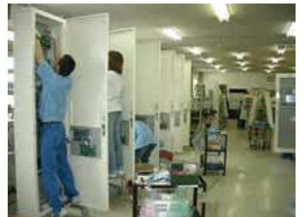
部品の組み込み作業
