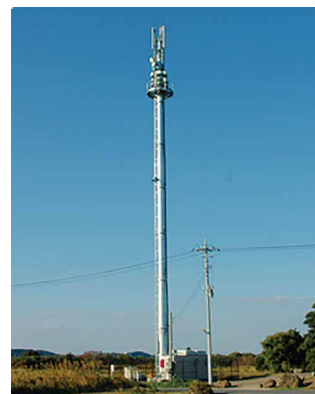
製品例:移動通信用鉄塔の製作・設置 厳しい建築基準をクリアする高度な設計技術が必要です
