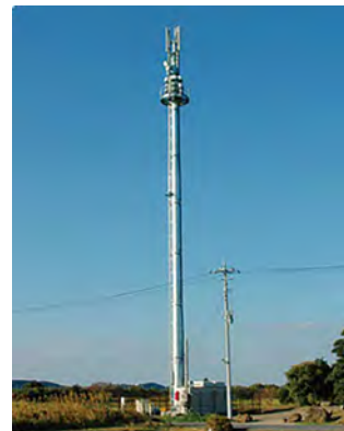
移動通信用鉄塔の製作・設置 厳しい建築基準をクリアする高度な設計技術が必要です
