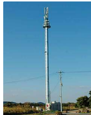
移動通信用鉄塔の製作・設置 厳しい建築基準をクリアする高度な設計技術が必要です
