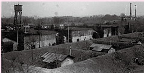
防爆壁と土塁に囲まれた工場と倉庫
