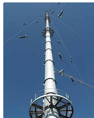
長波支線式送信鉄塔 国内でも特殊な長波支線式鉄塔アンテナの設計・製作・建設工事を行い、メンテナンスまで一貫して手がけています
