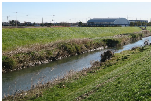
新河岸川沿いの斜面緑地
