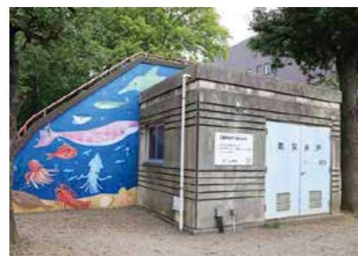
▲遊具と一体となった飲料用井戸（西ノ原中央公園）
