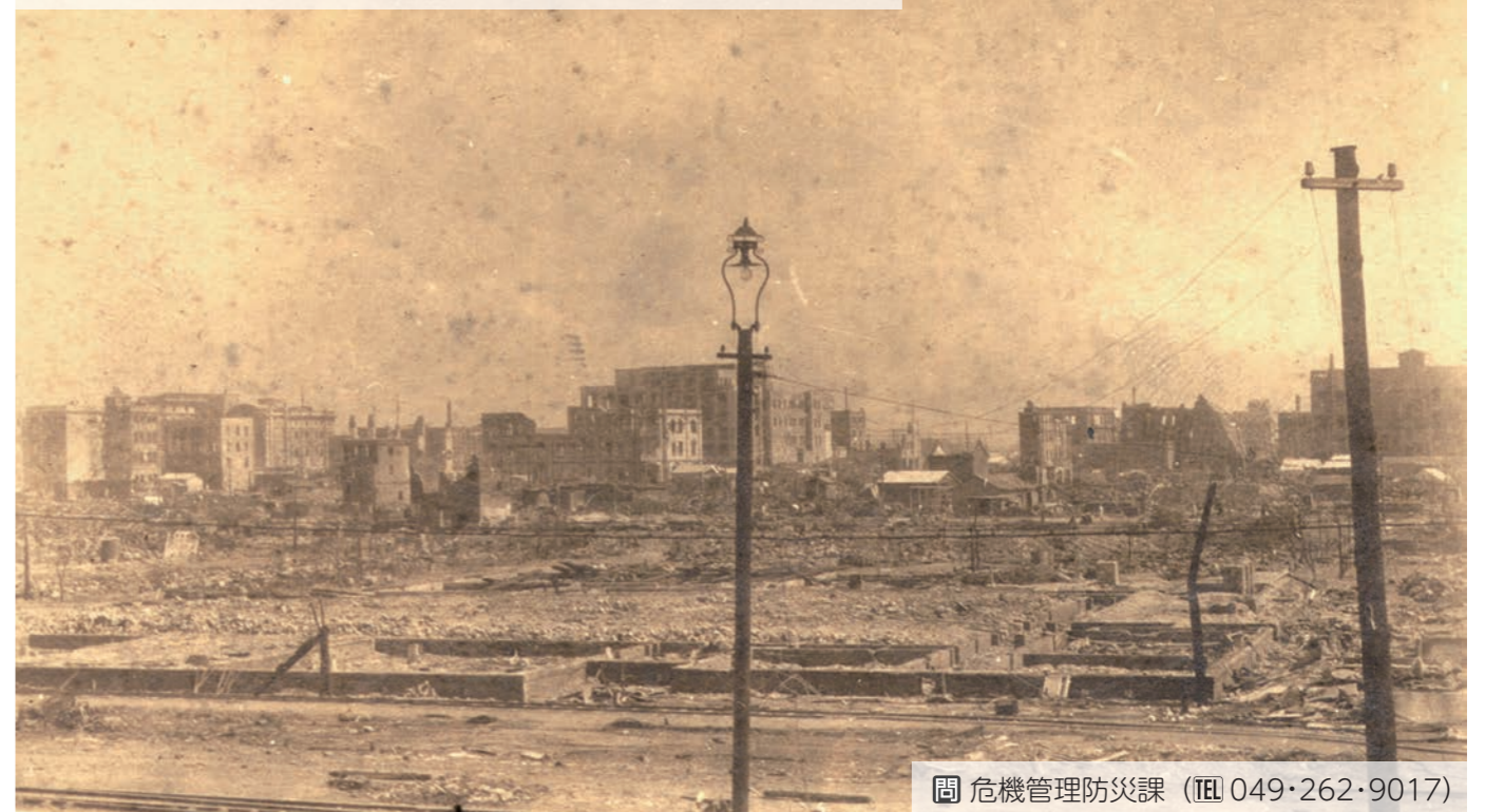
東京駅前の焼け跡、日本橋方面の様子 出典：国土交通省 気象庁ホームページ「関東大震災から100年」特設サイト
