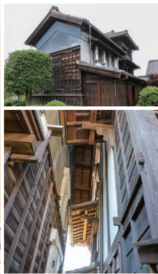
▲離れと文庫蔵の間。壁と屋根は建築物としても見どころ。
