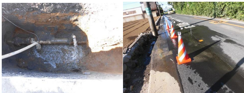
【老朽化により穴が開いた水道管】
