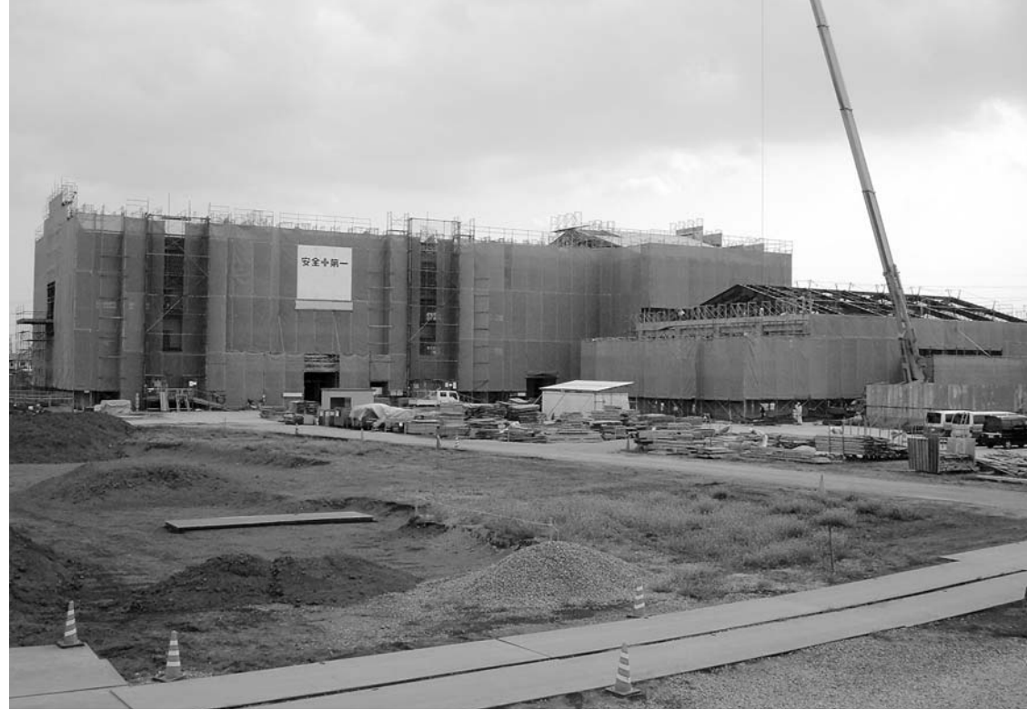
平成21年4月開校に向け建設が進む東台小学校
