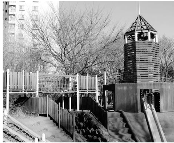
修繕を行なった公園遊具
