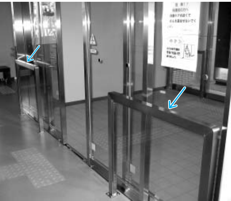
防護柵（青い矢印部分）が設置された自動ドア
