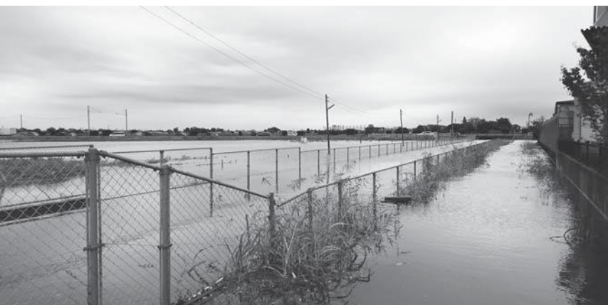
水宮地区の被害状況
