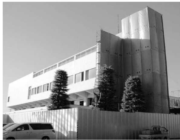
解体の進む大井総合支所
