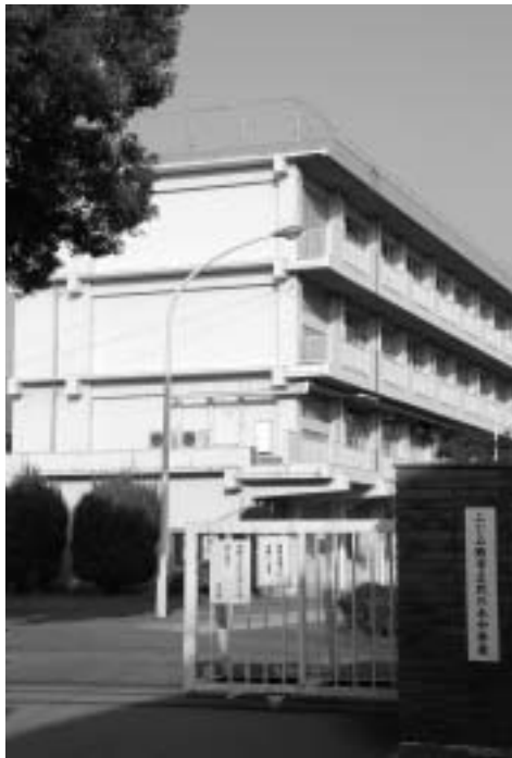
耐震工事が待たれる花の木中学校
