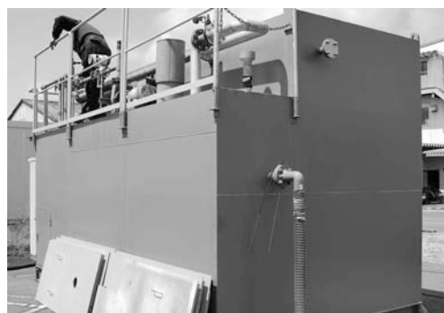
膜分離活性汚泥方式による移動式浄化槽
