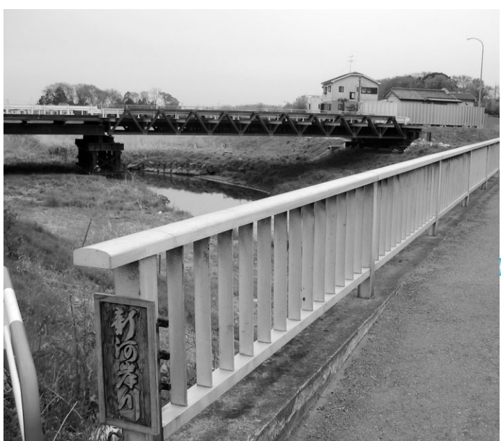
工事中の川崎橋
