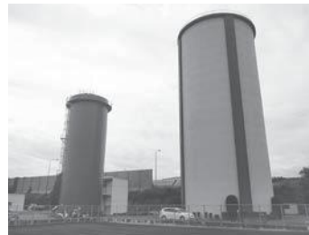
大井浄水場の排水塔
