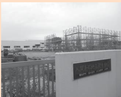
建築中のし尿処理施設
