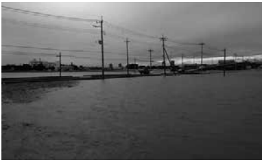
冠水した福岡江川右岸
