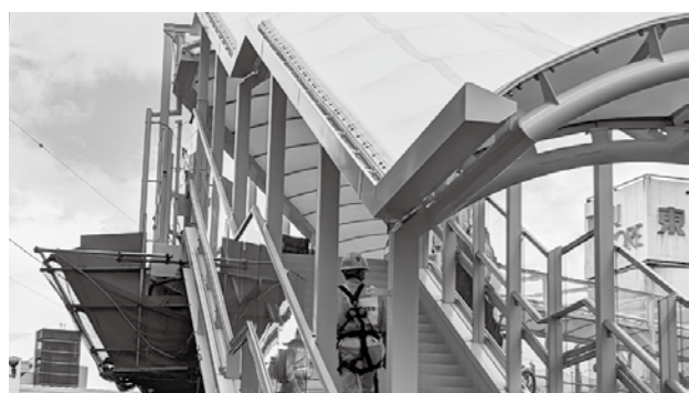
東口暫定歩道橋
