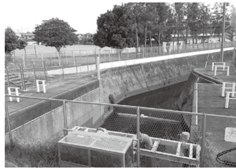
川越江川都市下水道
