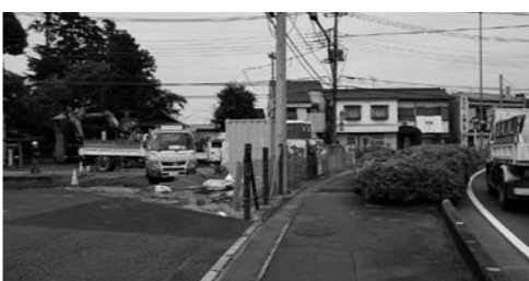
上沢勝瀬通り線整備工事
