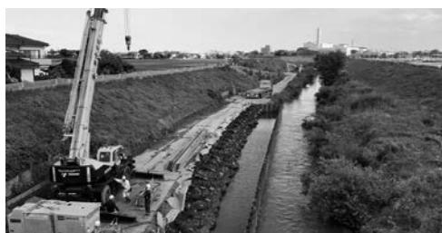
新河岸川の護岸改修工事
