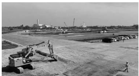
国道 254 号バイパス土地区画整理事業
