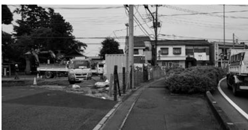
上沢勝瀬通り線整備工事
