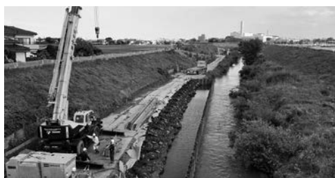
新河岸川の護岸改修工事
