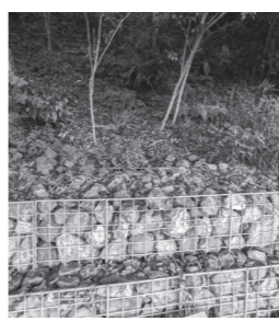
公園斜面林の崩落防止
