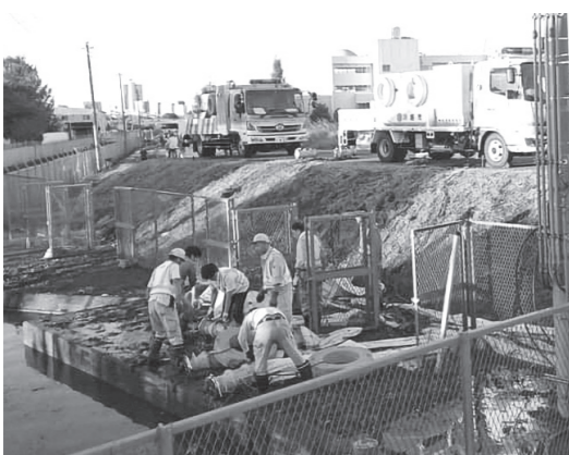
令和元年台風第19号時の排水作業
