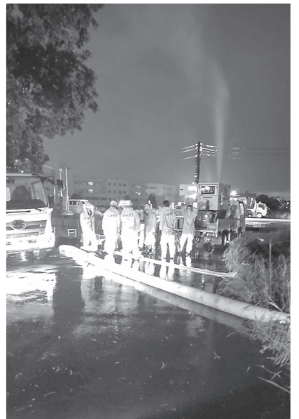
ポンプ車による排水作業
