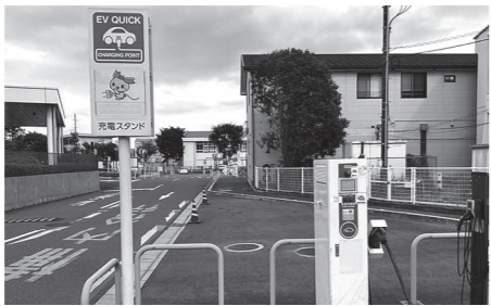
本庁舎の充電設備
