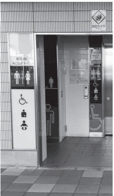
近隣で新設された多目的トイレ
