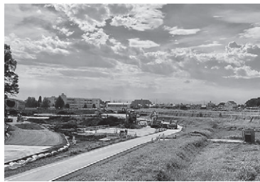
完成が待たれる川崎調整池
