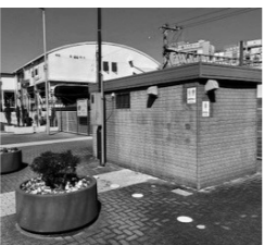
設置から20年の仮設トイレ
