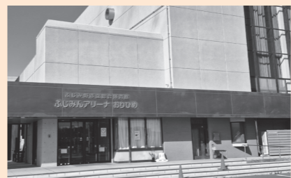
より快適なスポーツセンターへ
