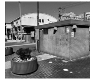
設置から20年の仮設トイレ
