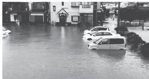
台風の被害を受けた中丸地区
