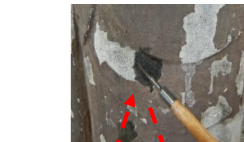
⑥ ほみ 矧ぎ目の木屎漆による充填整形補修。
