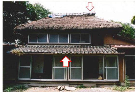
平成 9(1997)年ごろまで残されていた早船屋の建物<sup>けた</sup>。桁方向からの強い地震波をうけたとみられ、瓦と下屋屋根が波打っていたようすがうかがわれた。
