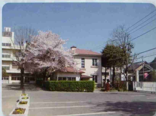
東側からの現況
